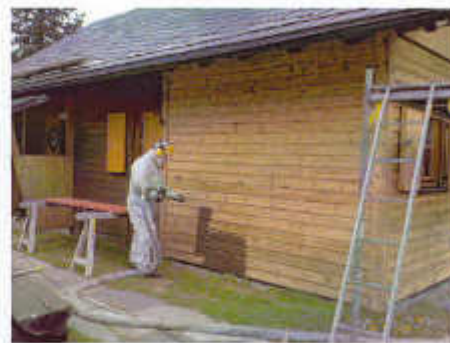
Mit Trockeneis wurde die komplette Fassade der Schneeberghütte abgestrahlt.
